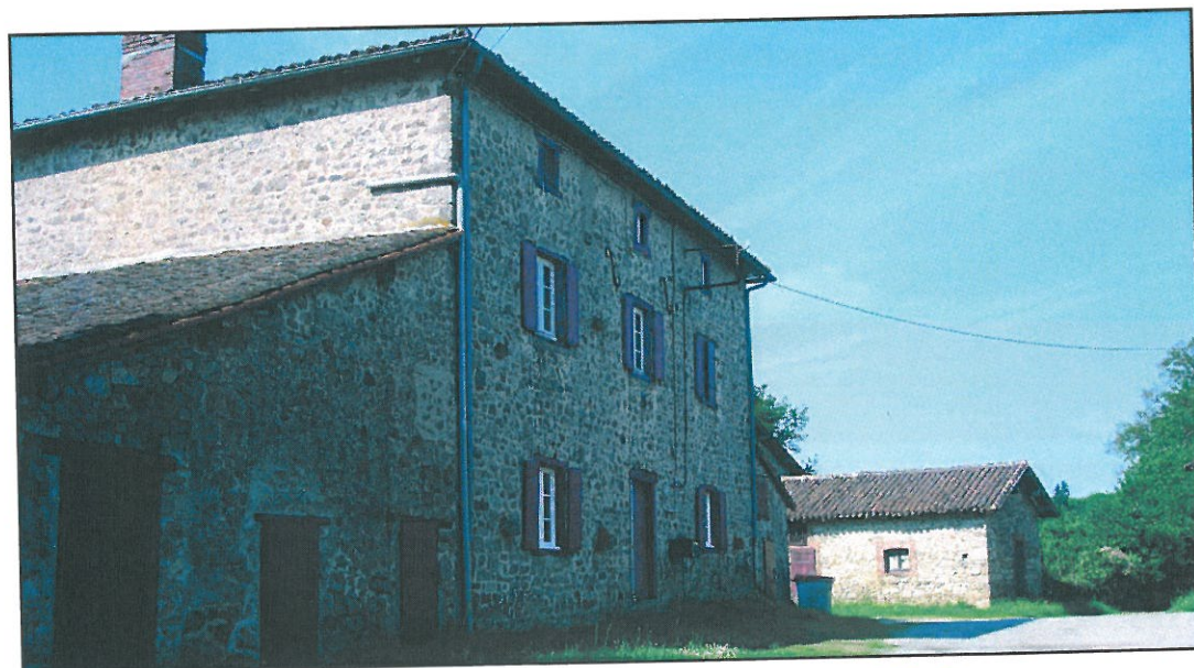
Les constructions de Mont situées sur l'aire d'étude
