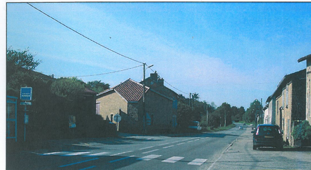
La RN 147 dans sa traversée de Conore
