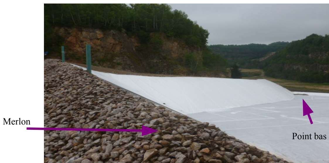
Stockage vu depuis la zone de déchargement. Au premier plan, un merlon permet d'éviter la chute d'engins dans le stockage (au fond, le point bas qui permet l'écoulement gravitaire des lixiviats).
