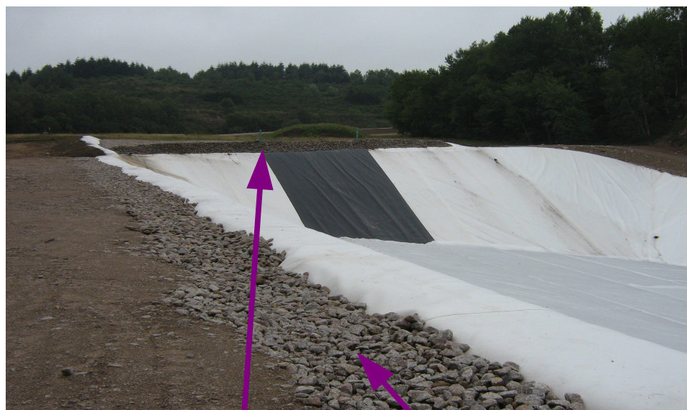
Casier avec zone de déchargement (au fond). Au premier plan, le long de la membrane (recouvert de cailloux), un fossé de collecte des eaux pluviales.
