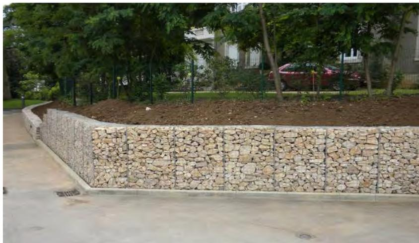
Photo 11 : Murets en gabion installés sur le site (Source ARTELIA)
