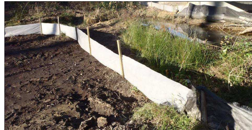
Implantation de barrières amphibiens en géotextile permettant d'éviter les déplacements des individus du cours d'eau vers le chantier © ETEN Environnement
