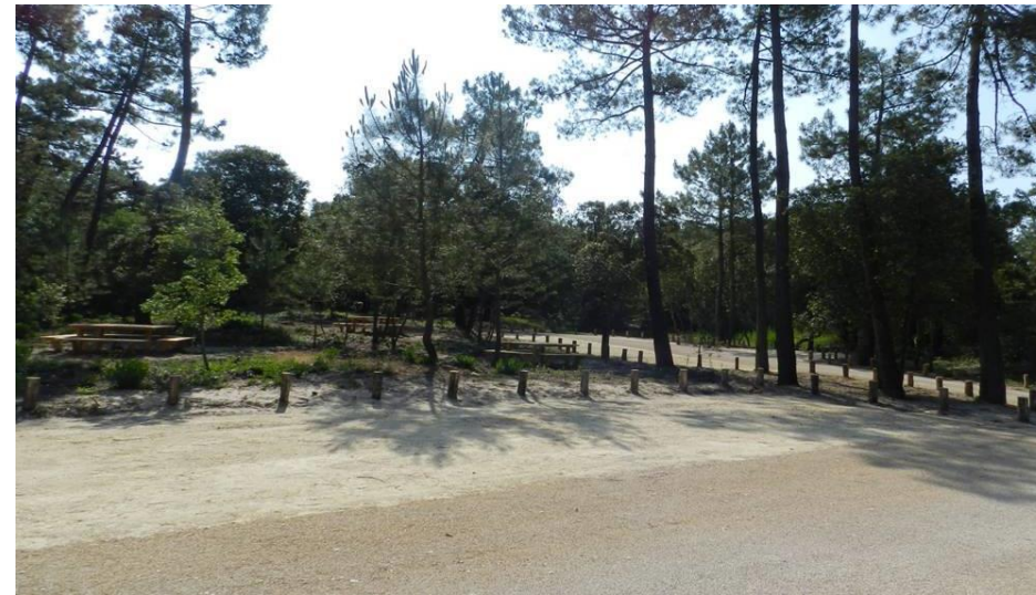
Sol en calcaire compacté pour l'accès secours et les abords décaissés du poste MNS
