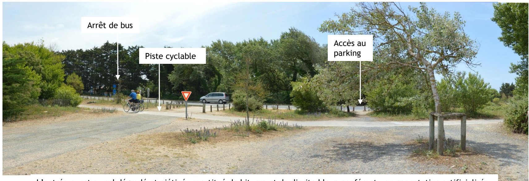
L'entrée ouest au sol dégradé et piétiné, constitué de bitume et de diorite bleue conférant une connotation artificialisée
