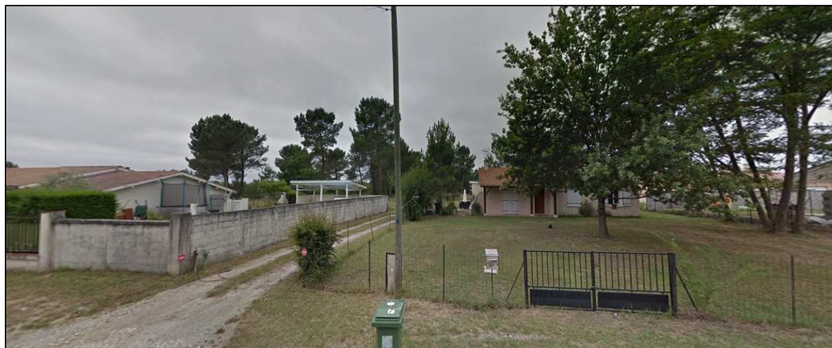
Prise de vue n°1, depuis l'allée des Duragnes (le site du projet est situé derrière les habitations)
