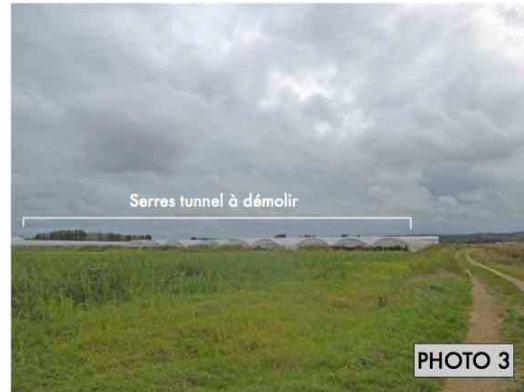
A 2 Photos des serres à démolir dans leur environnement proche
