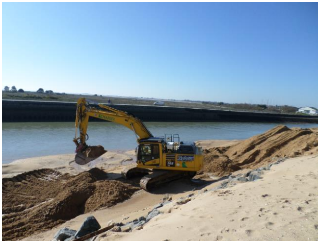
Extraction mécanique du sable Chenal de La Perrotine PAPI 2019 (@CDC IO)
