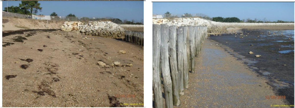
Figure 39 : clichés photographiques localisant la limite visible d'emprise du chantier (rangée de pieux)
