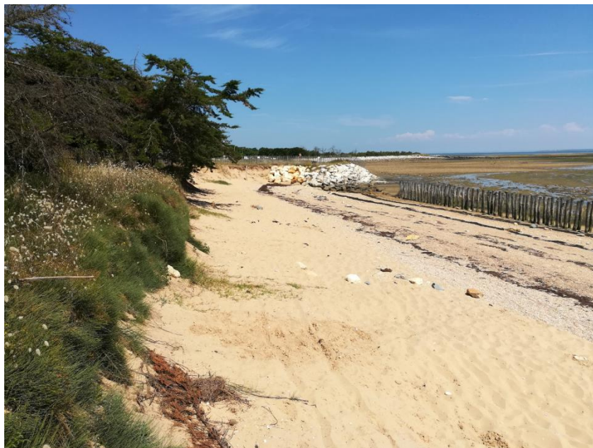
Figure 10 : Etat initial avant travaux
