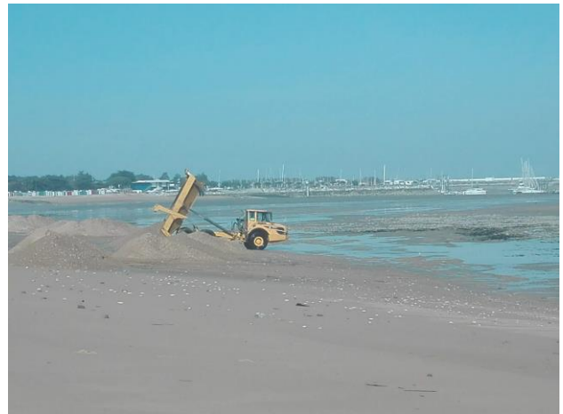
Ré-ensemblage Plages Boirie dans le cadre de l'entretien des casiers portuaires de St Denis (@CDC IO 2019)
