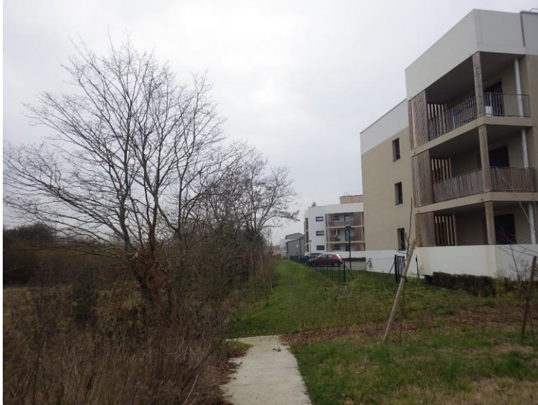
Photographie de la lisière boisée en limite Nord (©CERAG 21/12/2017)
