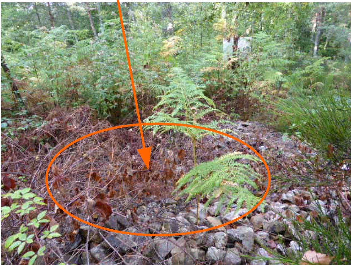
affaissement au droit du puits
