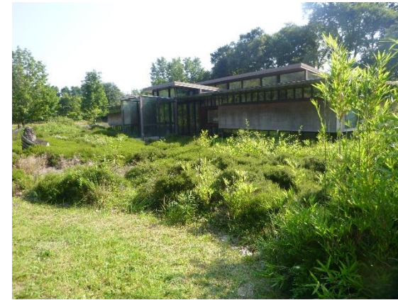
Bâtiment et espaces verts
