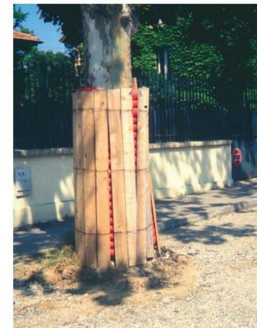
Figure 12 : Technique de protection temporaire du tronc
