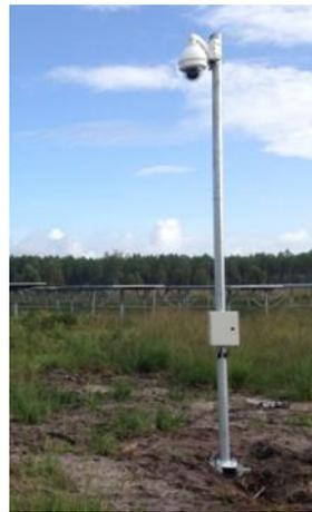
**Fig. 13. Caméra de surveillance « fixe » ou « dôme »**
