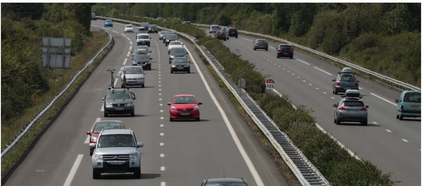
Trafic automobile sur l'autoroute A10 dans la Vienne. Crédit photo : Olivier Prévost
