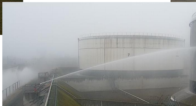
Feu de la cuvette du réservoir n°6
