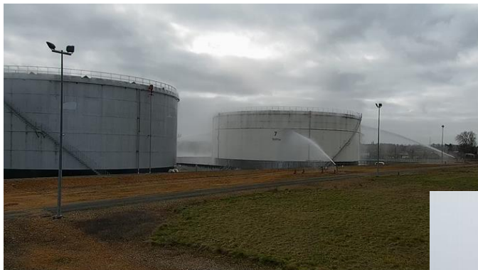
Feu de cuvette du réservoir n°7
