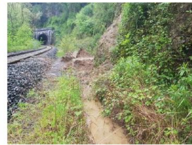
Glissement du 15 avril 2020 – vue vers Oloron
