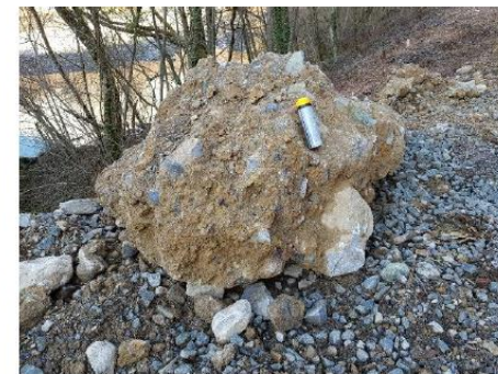
15 décembre 2021 - Evacuation blocs après purge - volume total 2m 3
