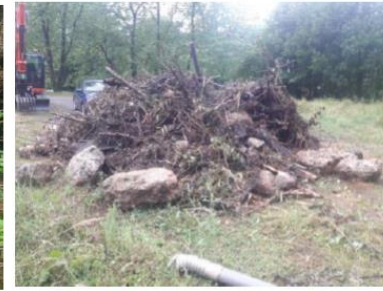
Mai 2020 – Opération de purge
