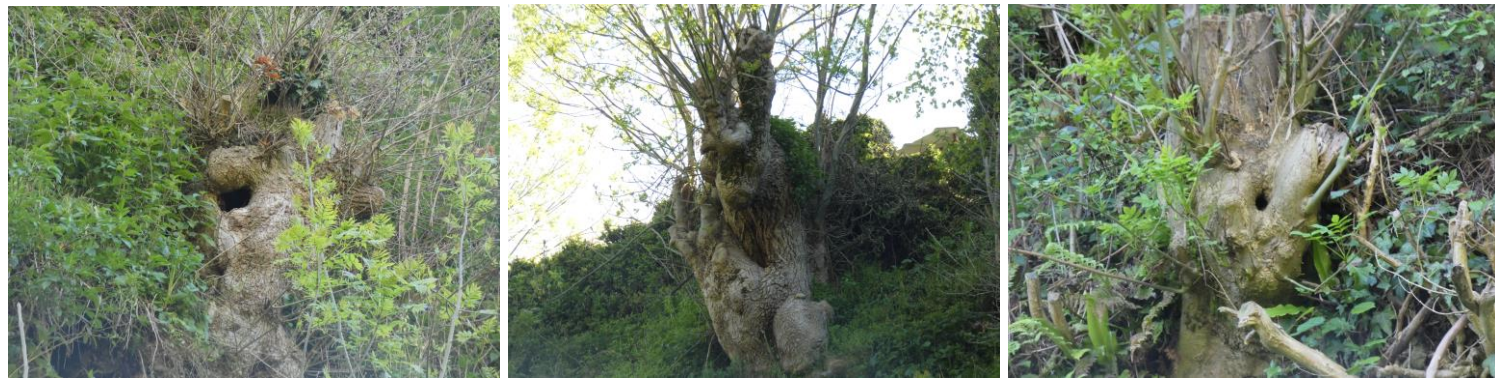
Figure 12 : Gîtes arboricoles potentiels au-dessus du mur de soutènement [Source : SIMETHIS, 2022]
