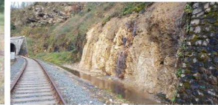
Octobre/ novembre 2020 – Déroctage des concrétions calcaires
