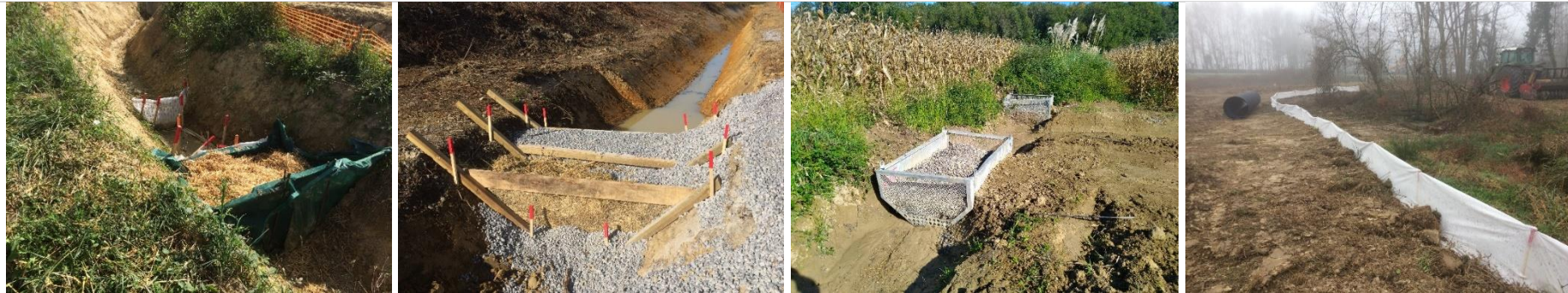
Figure 15 : Exemple de système de filtration [Source : SIMETHIS]
