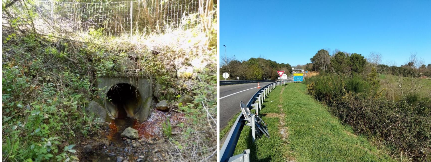
Figure 5 : Cours d'eau busé passant sous l'autoroute A63 [Source : SIMETHIS, 2020/2021]
