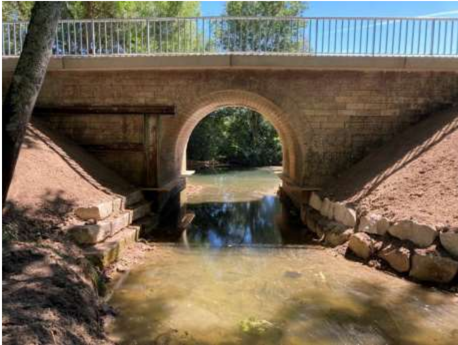
RD117 - Pont de Guissalle OH4 (Vars - 2022)
