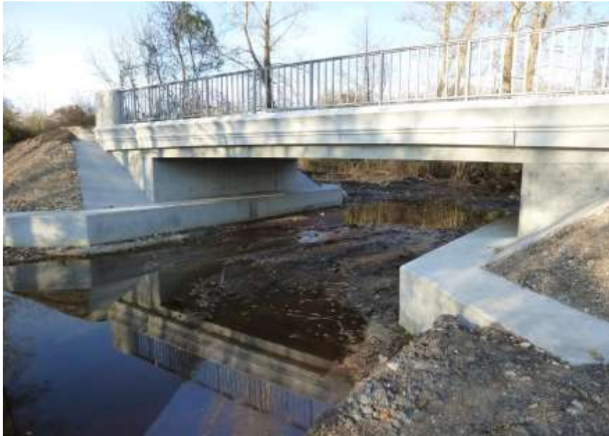
RD81 - Pont des Gardaiches (Gurat - 2013)
