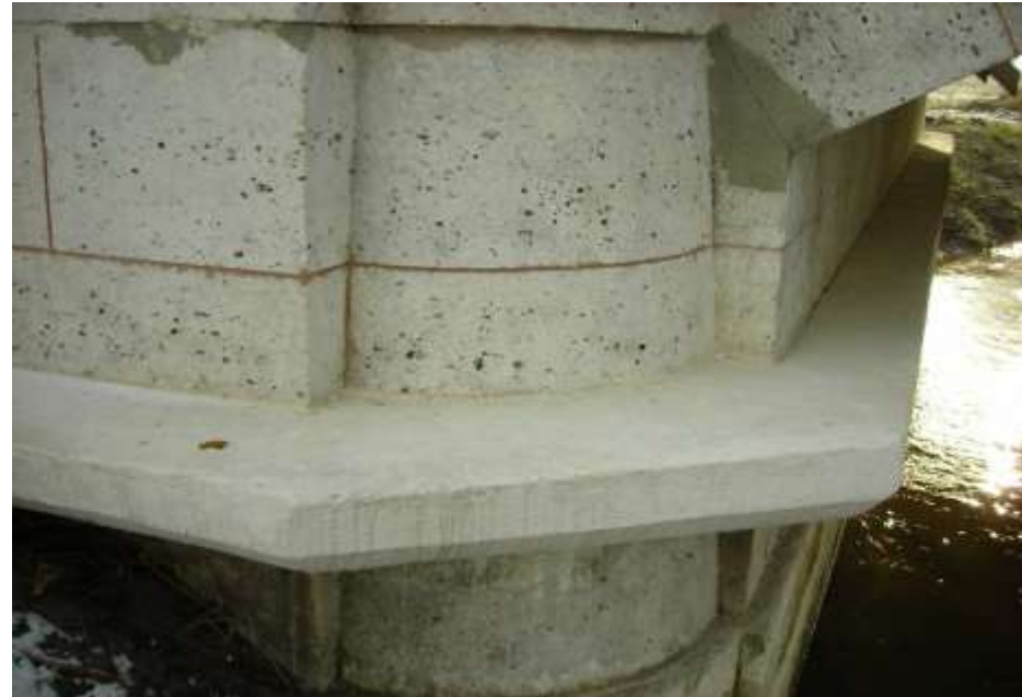
RD 5 Pont du Moulin Brousset (2009)
