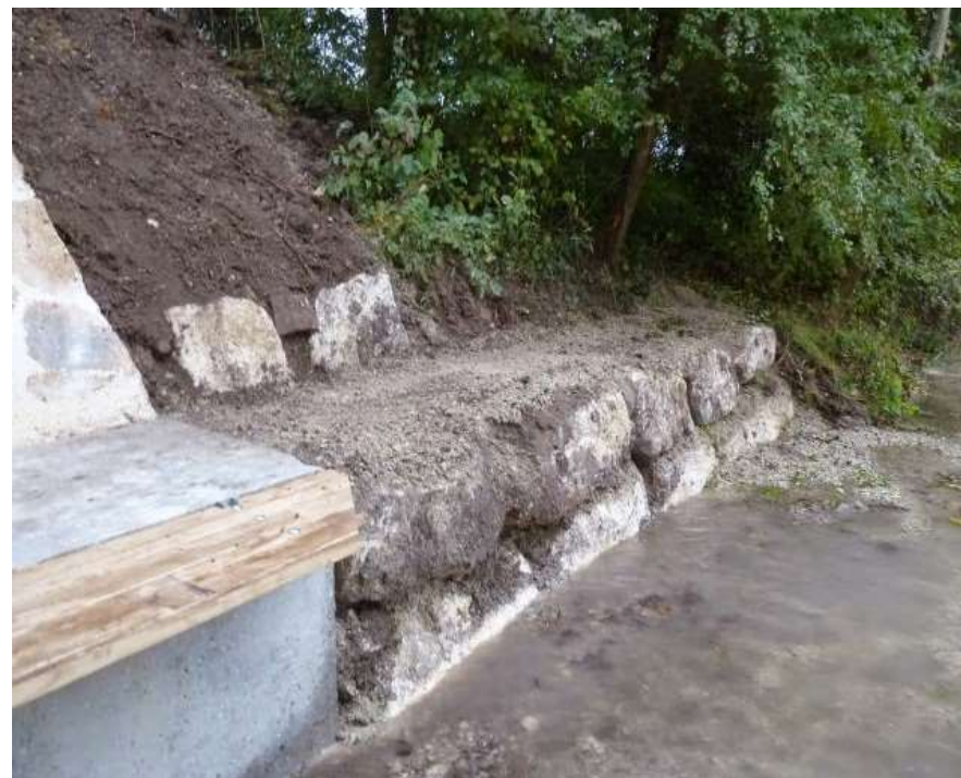
RD147 - Pont du Port de Jappe (Salignac/Charente - 2014)
