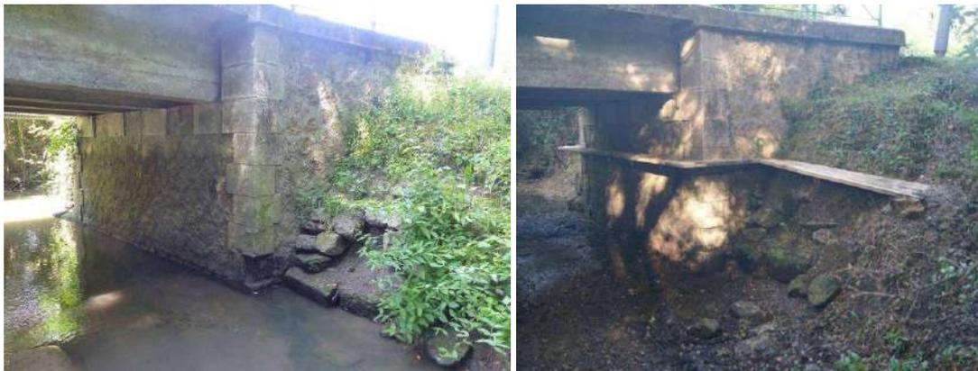
*Figure 21 : Exemple d'aménagement pour la transparence écologique d'un ouvrage d'art par l'installation d'un encorbellement (© CD33)*
