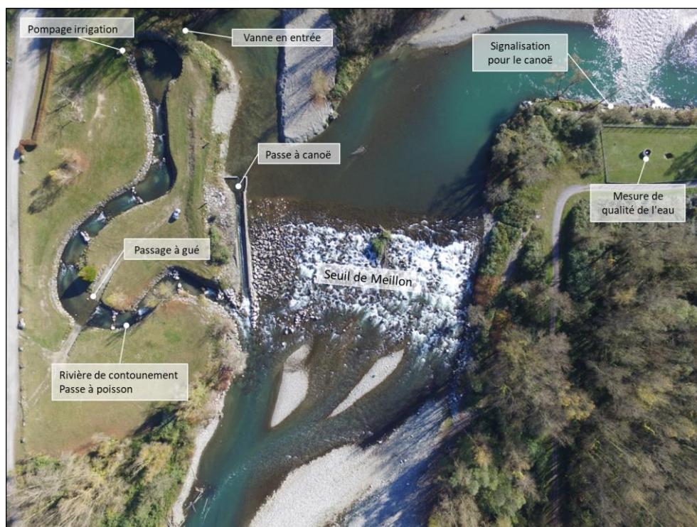
Figure 2. Vue aérienne du seuil
