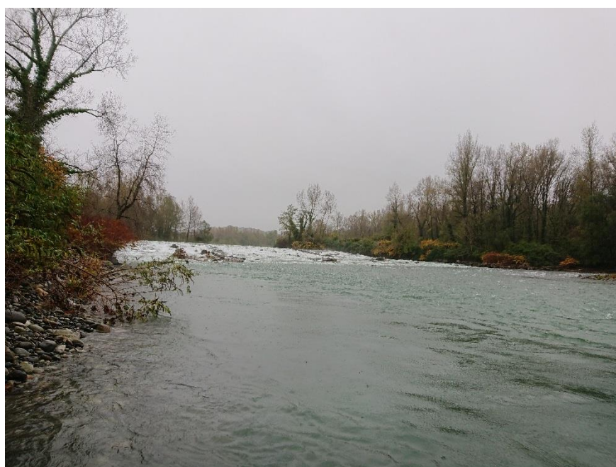
Vue d'ensemble aval du seuil (habitats favorables au Chabot)
