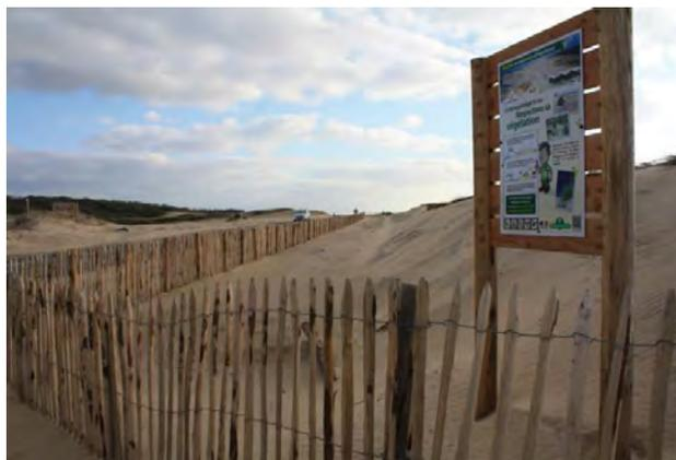
*Figure 28 : Exemple de ganivelle servant à canaliser le public accompagné d'un panneau d'information [Source : © L. Gouguet/ONF - Guide de gestion des dunes et des plages associées]*
