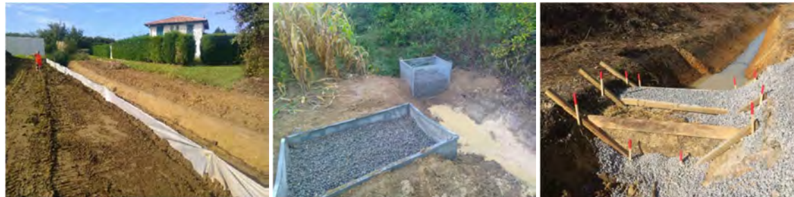
Exemples de systèmes de filtration sur un chantier de construction (Source : Simethis)
