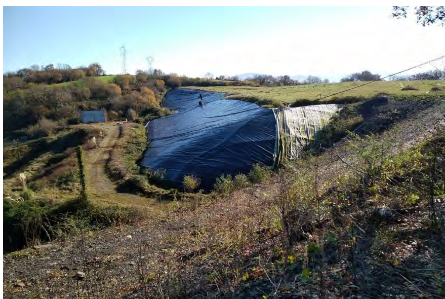
Photo 1 : Vue des bâches imperméables au sein de la zone d'étude immédiate pour récupérer le méthane et les lixiviats (14/12/2021)
