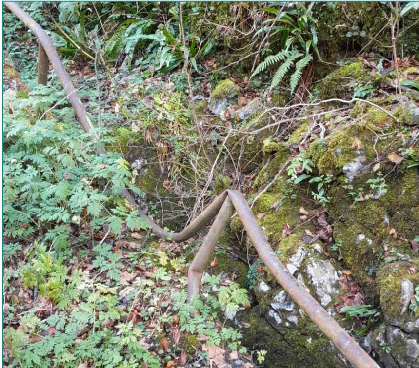
Rambarde du pont intermédiaire détruite lors de la chute d'un arbre durant la dernière tempête
