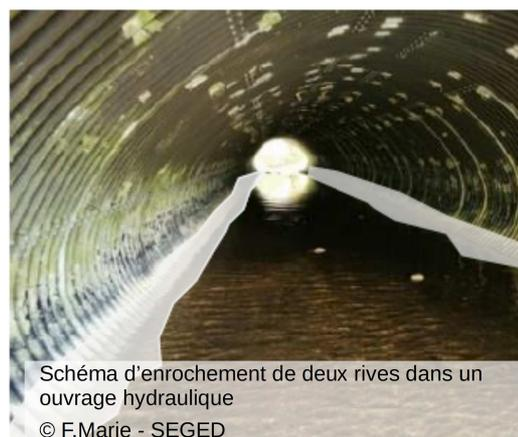
Schéma d'enrochement de deux rives dans un ouvrage hydraulique
