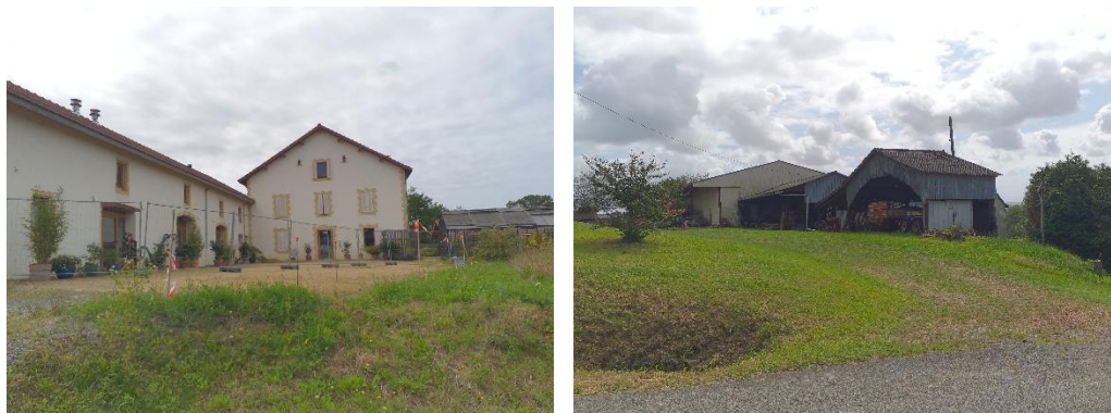
Figure 30 : Ferme de Meyrin à gauche, hangar agricole route de Brassempouy à droite
