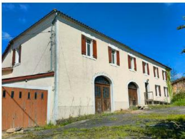
I2.6 Maison à l'abandon
