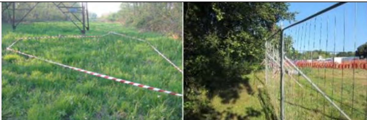
Figure 74 : Exemple de balisage : plante protégée en Sologne, préalable à des travaux sur pylône (gauche) ; Protection de haie dans le cadre de la création d'un tunnel (droite)
