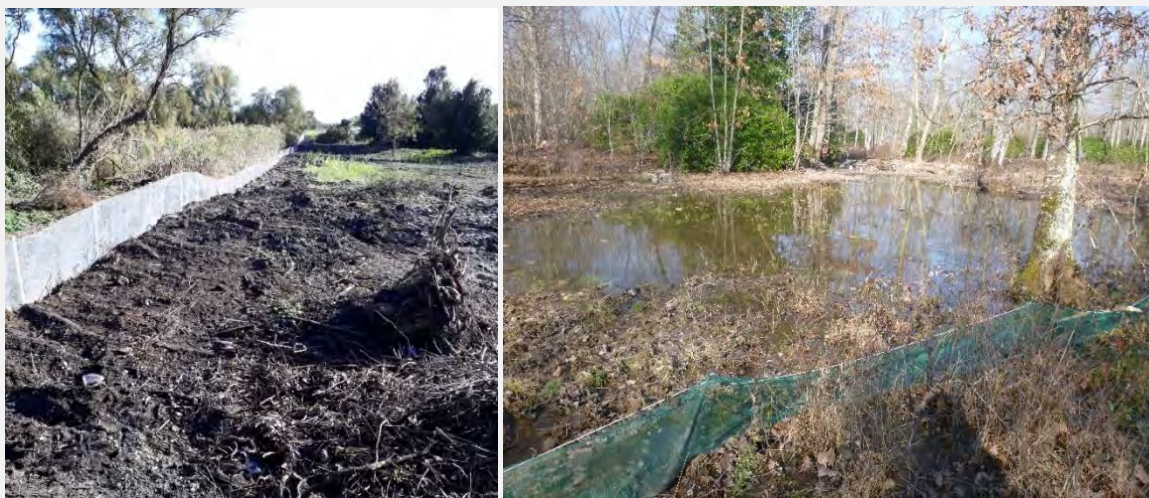
Figure 76 : Exemple de clôture anti-intrusion à amphibiens installée sur des sites à La Rochelle et à Bordeaux, SCE
