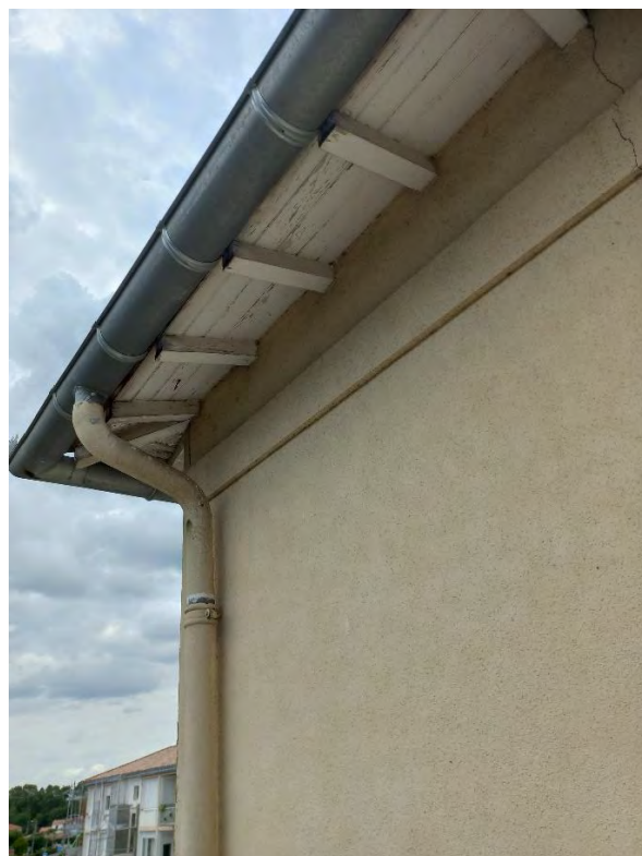
Avants toits état actuels
