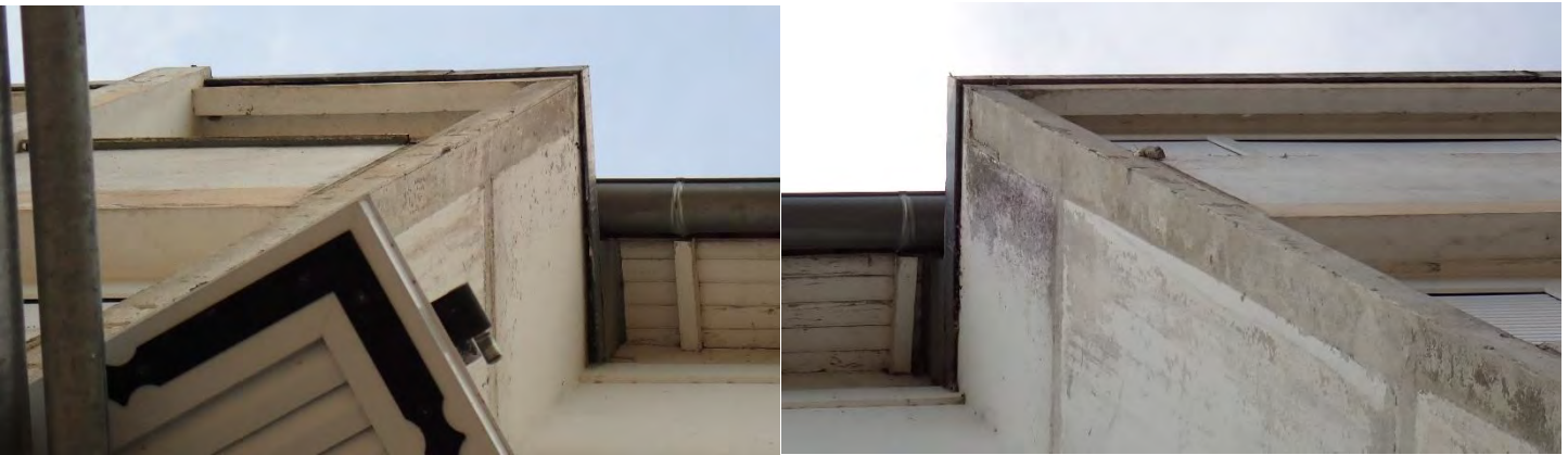
Figure 17 : Fente où sont localisées une partie des Pipistrelles au sein de la façade Sud (13/08/2024)
