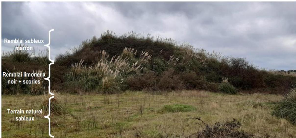
Figure 5 : Illustration de la stratification des terrains (APAVE 2022)
