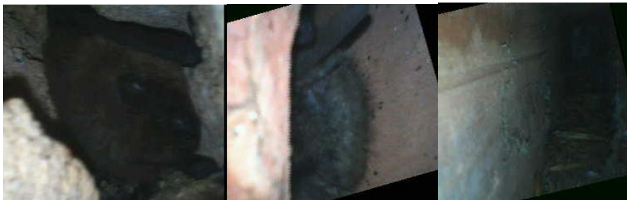
Figure 6: Pipistrelle sp. / Chiro sp. / Brique creuse en façade (Carto-Echo 2026)
