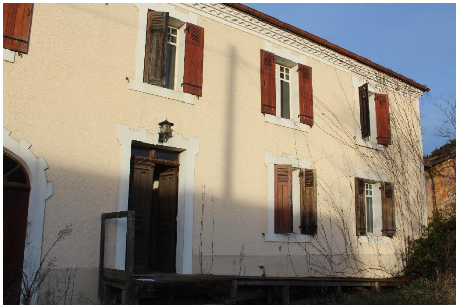
Figure 1: Extérieur de la maison principale (Carto-Echo 2026)
