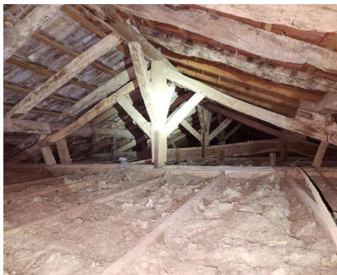
Figure 8 : Combles du bâtiment
