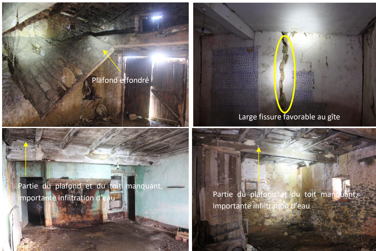
Figure 7: Pièces intérieures de la grange (Carto-Echo 2026)
