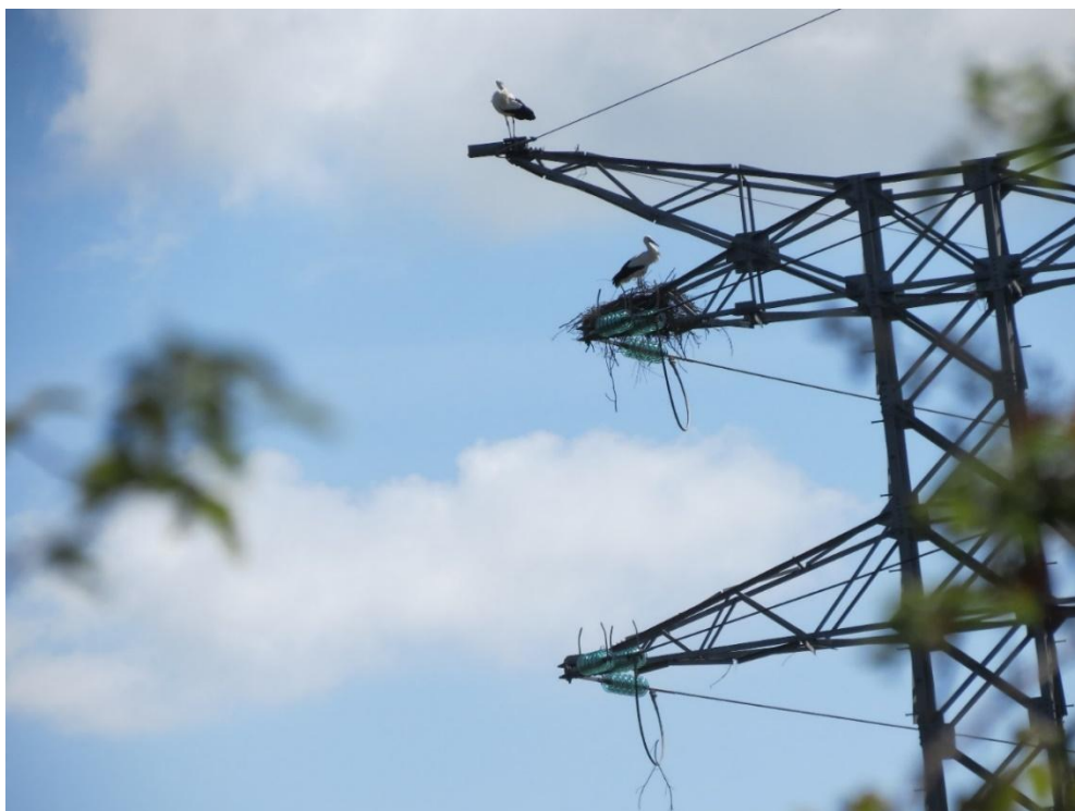
Figure 50 : Exemple d'un nouveau nid de Cigogne blanche en construction sur un pylône RTE avec de nombreuses branches tombant sur les phases en dessous, pouvant provoquer des microcoupures. Avril 2023 - Secteur de Saintes - Charente-Maritime (Nicolas GENDRE / LPO).
