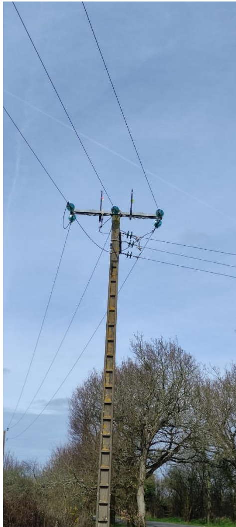
Figure 33 : Pose de dispositif anti-nidification le 22 mars 2023, où par chance, le couple de Cigogne blanche s'est installé ensuite sur le réseau RTE. Ce dispositif n'est pas optimal pour empêcher la Cigogne blanche de nicher et peut avoir l'effet inverse. Installation à Braz à Montoir (44) (ACROLA).
