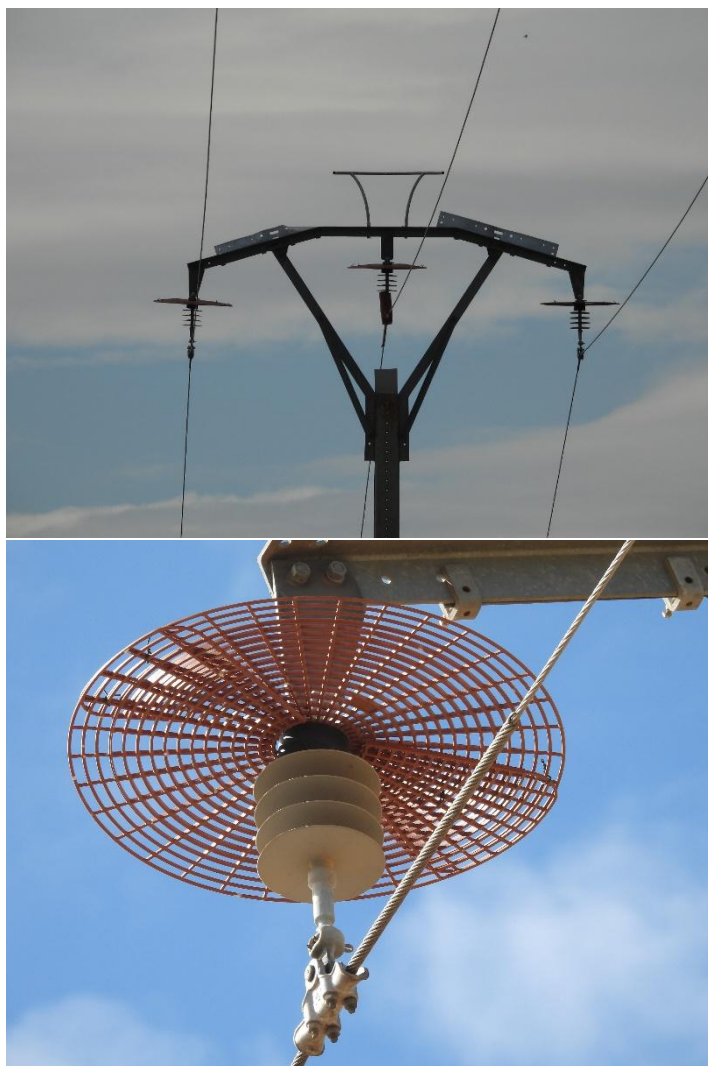
Figures 66 & 67 : Exemples de dispositif avifaune (des dispositifs équivalents sont utilisés par RTE) pour empêcher les oiseaux (notamment les cigognes et les rapaces notamment vautours) de se poser et un perchoir proposé à étudier. Chaque phase a une coupelle de protection (Nicolas CROIZE / LPO).
