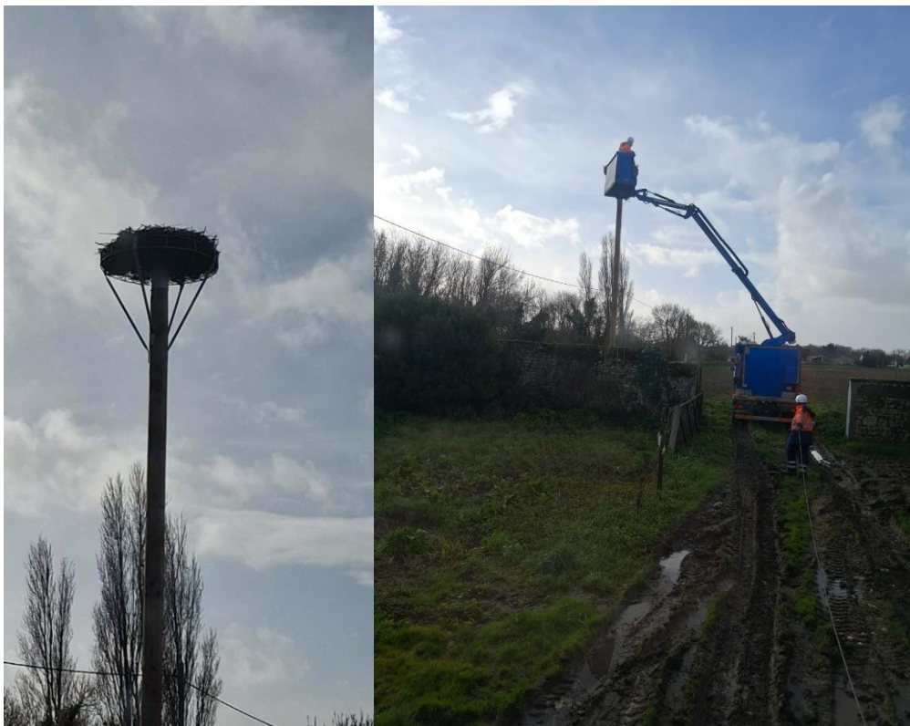
Figures 90 & 91 : Plateforme ronde de compensation installée à la Haute-Roche à Saint-Laurent-de-la-Prée (17) et déplacement du nid le 23 janvier 2026 (Aurélien VERBEEK / Enedis Poitou-Charentes)
