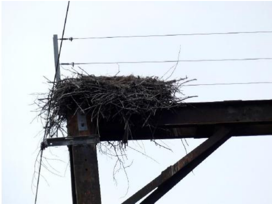
Figure 53 : Nid de Cigogne blanche construit sur un poteau caténaire à Arveyres malgré la pose de câbles (J. LAZARD)
