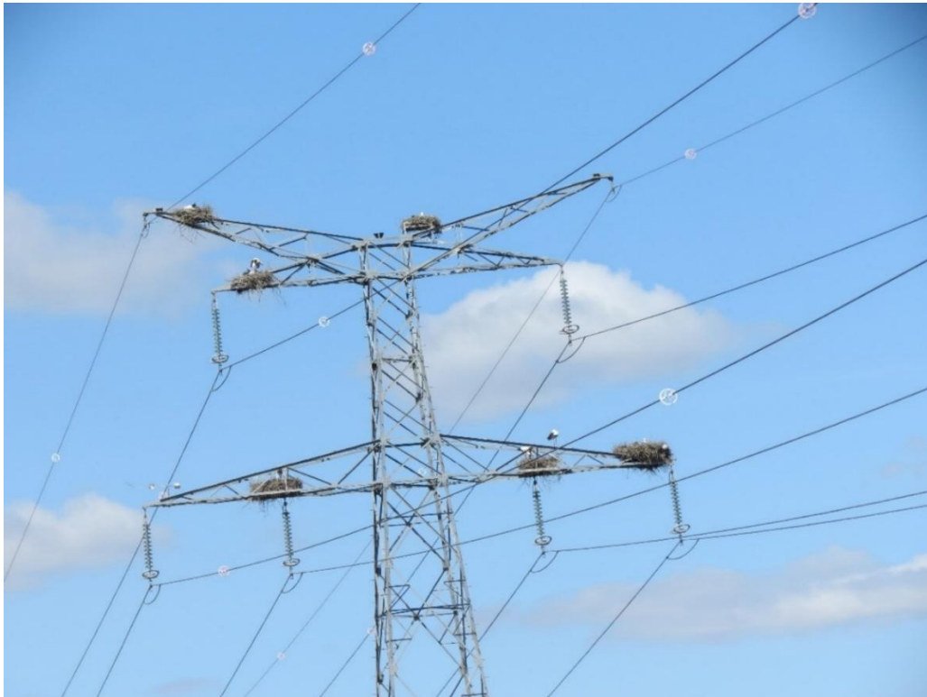
Figures 47, 48 & 49 : Exemples de pylônes RTE fréquentés avec un nombre important de nids de Cigogne blanche dans le secteur de Saintes en Charente-Maritime en avril 2023, avant l'opération de sécurisation de fin 2024 (Nicolas GENDRE / LPO).
