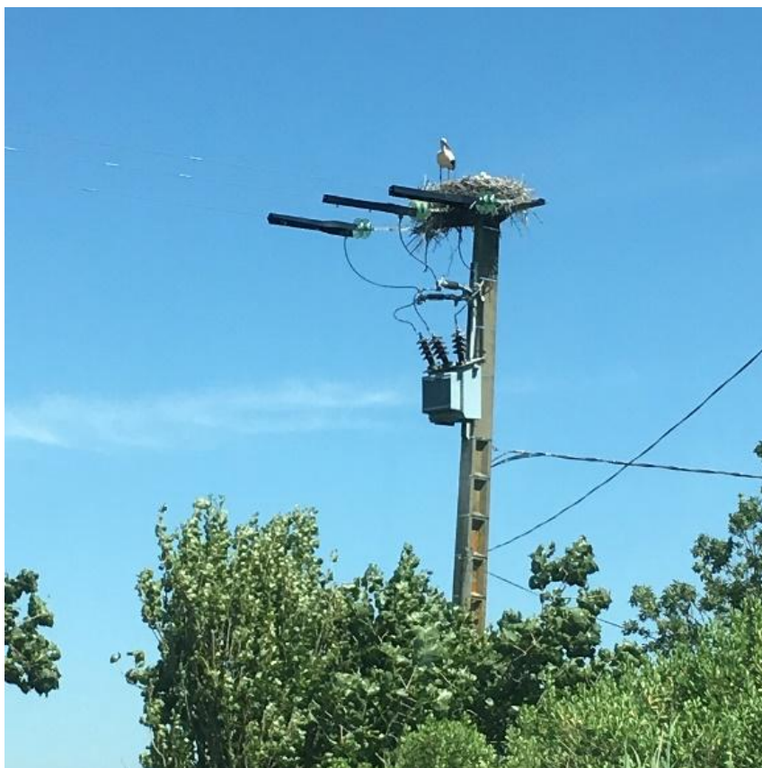
Figure 22 : Protections temporaires isolantes d'un nid de Cigogne blanche sur un H61 d'Enedis en Charente-Maritime (Enedis Poitou-Charentes & LPO)
