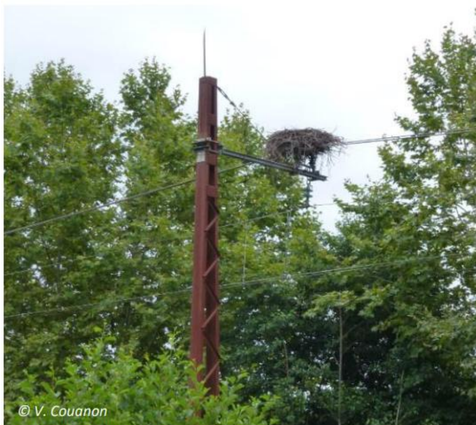
Figure 56 : Nid installé sur un poteau caténaire de la ligne Bayonne – Puyoô (Virginie COUANON - LPO Délégation territoriale Aquitaine)
