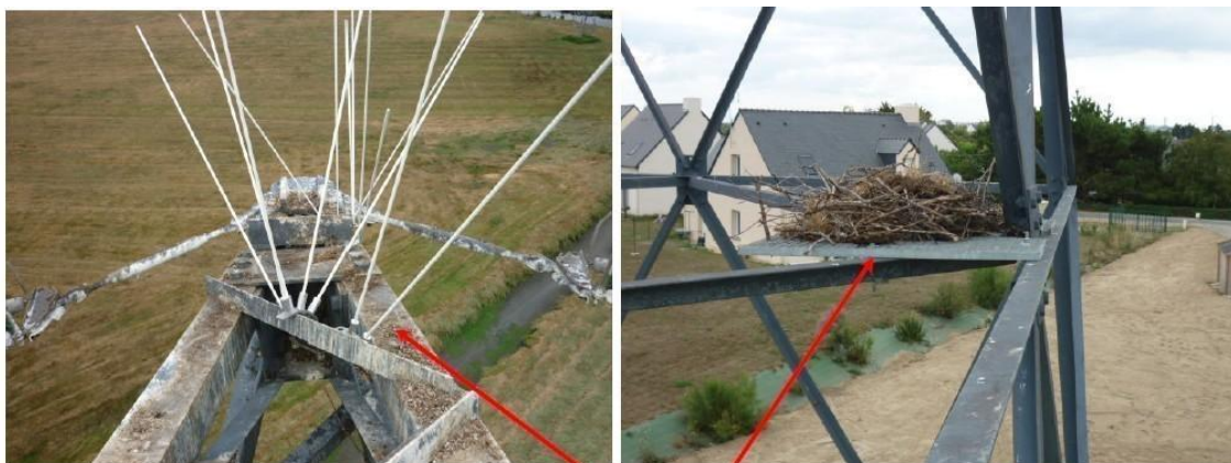
Figures 38 & 39 : Pose de pics PFISTERER et caillebotis pour l'accueil de nid (RTE)
