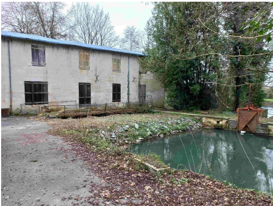
Figure 1 : Vue amont du Moulin de Bouzon
