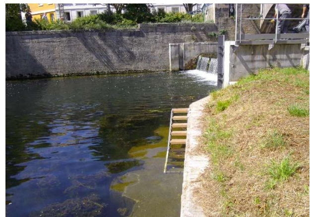
Figure 13 : Création d'un escalier par les serruriers de la ville pour le franchissement d'un ouvrage hydraulique
