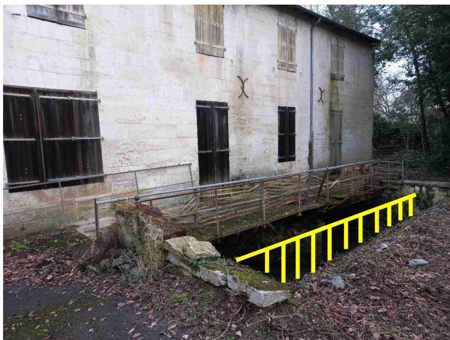
Emplacement du dégrilleur prévu
