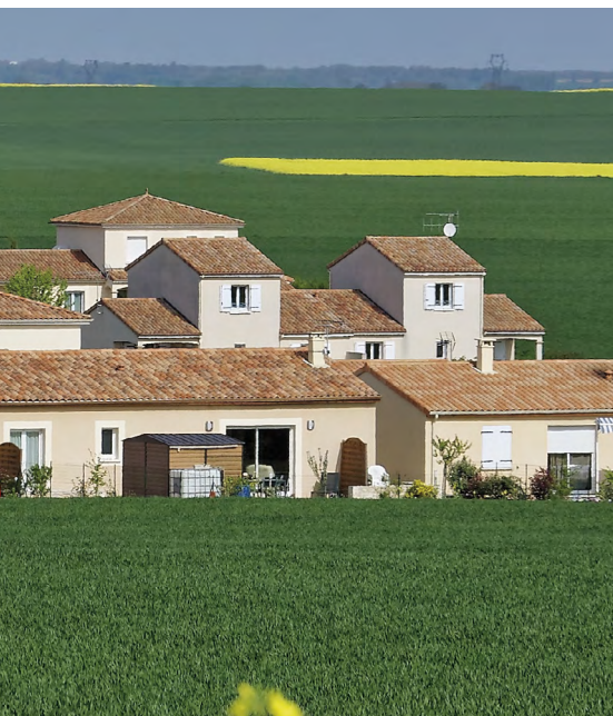
Lotissement au milieu des cultures à Chasseneuil-du-Poitou dans la Vienne.
