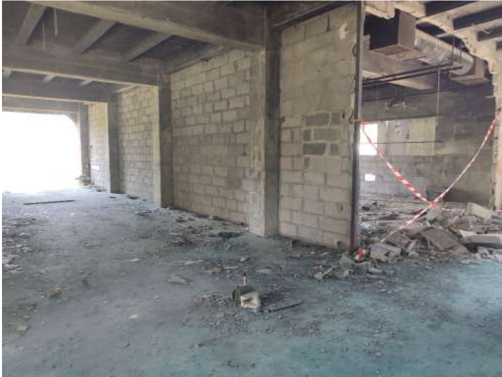
Figure 2: Vue partielle du premier étage
