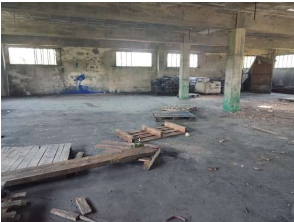
Figure 3: Vue partielle du 2ème étage
