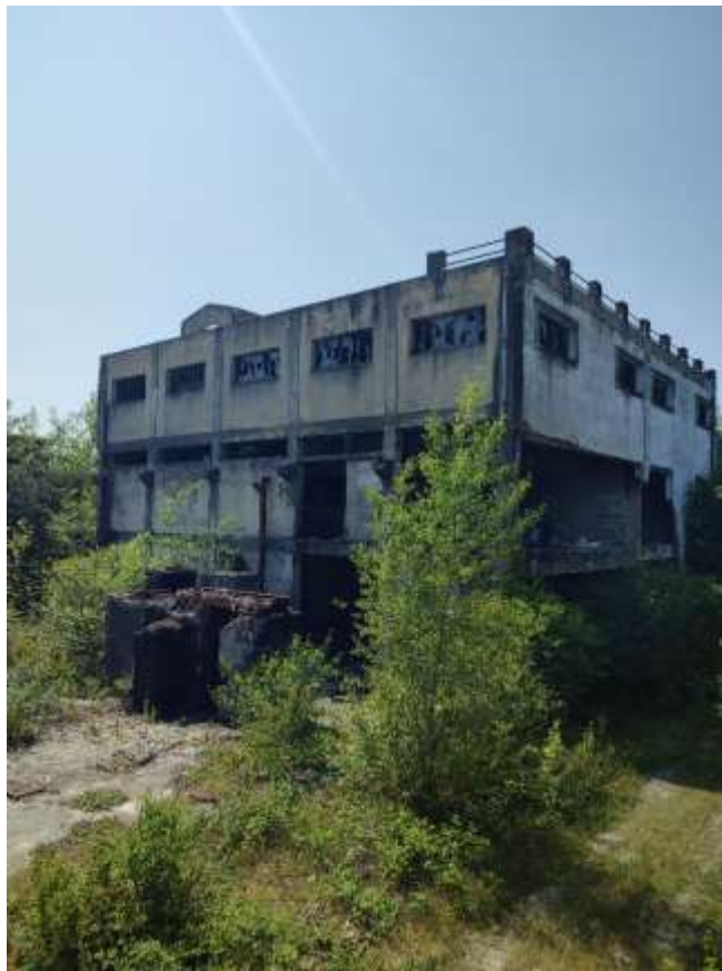
Figure 1: Vue générale du bâtiment diagnostiqué
