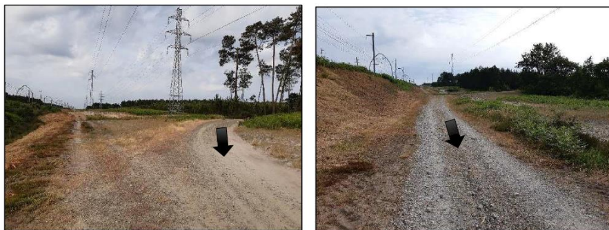
Pistes DFCI côté Ouest (à gauche) et Est (à droite). ING'EUROP
