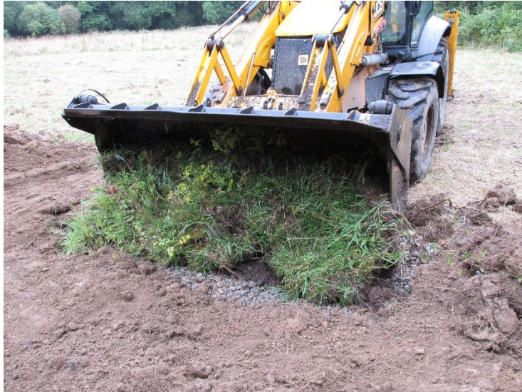
Figure 12. Dépôt de la plaque de végétation (station S2) sur la station d'accueil A2 - Photo Biotope
