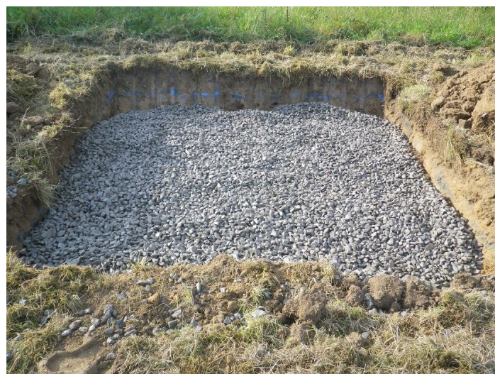
Figure 7. Fosses d'accueil des plaques de végétation avec lit de drainage - Photo Biotope
