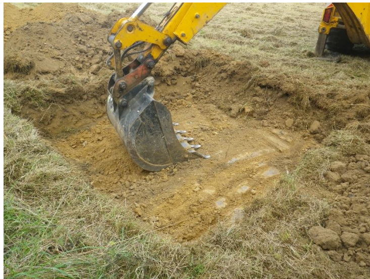
Figure 6. Creusement des fosses d'accueil des plaques de végétations - Photo Biotope
