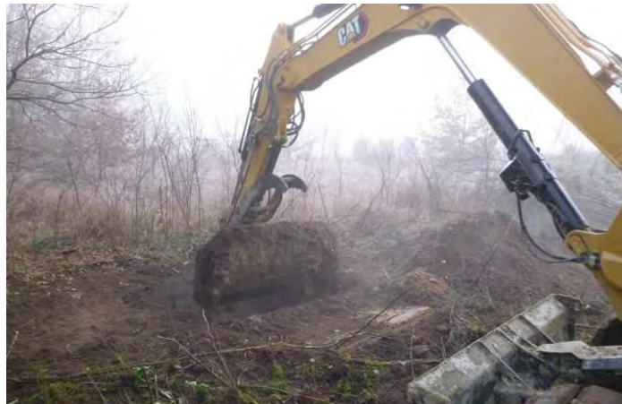
Réalisation d'une fosse pédologique au tractopelle sur le site ©ETEN Environnement, 26/01/2022
