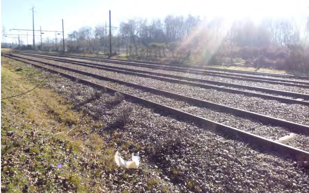
Voie ferrée dans l'aire d'étude ©ETEN Environnement, 14/12/2021
