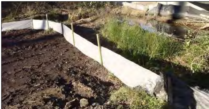
Implantation de barrières amphibies en géotextile permettant d'éviter les déplacements des individus des fossés vers le chantier © ETEN Environnement
