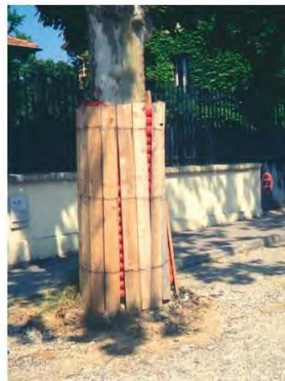
Figure 27 : Technique de protection temporaire du tronc
