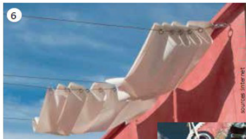
Exemple de toiles tendues et fixations sur câbles métalliques pour une meilleure résistance au vents >
