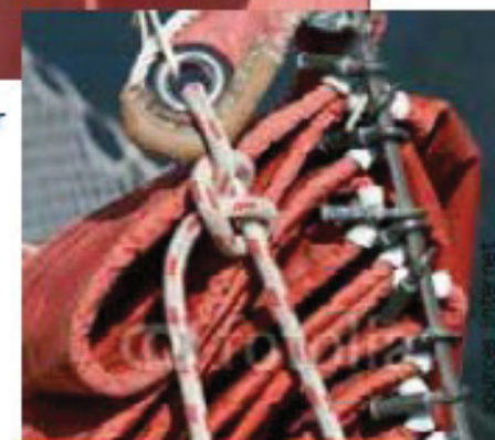
Exemple de toiles tendues et fixations sur câbles métalliques pour une meilleure résistance au vents >
