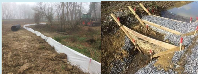
Figure 59 : Barrière temporaire anti-batrachiens (à gauche) et filtre à paille/cailloux (à droite) [Source : SIMETHIS, 2019]
