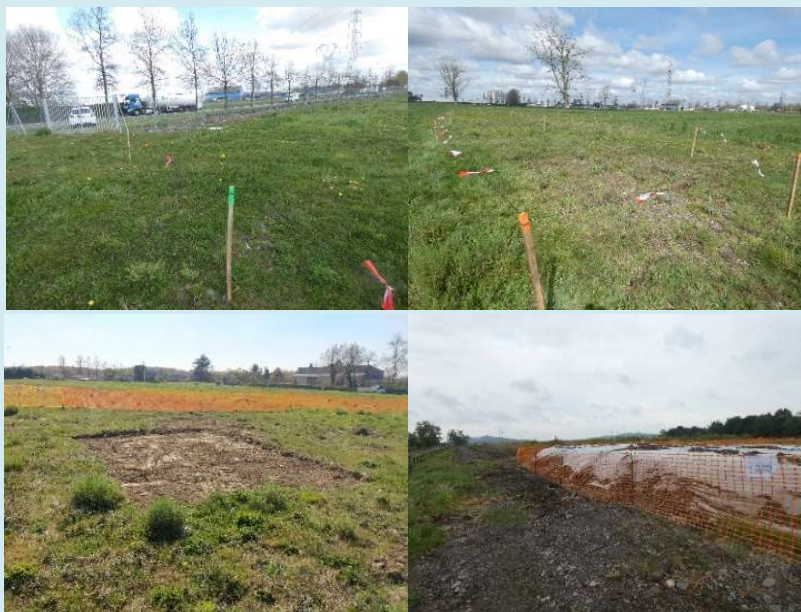
Figure 57 : De gauche à droite : balisage de stations floristiques, décapage des horizons superficiels et merlon de stockage des banquettes de terre (Source : Simethis)
