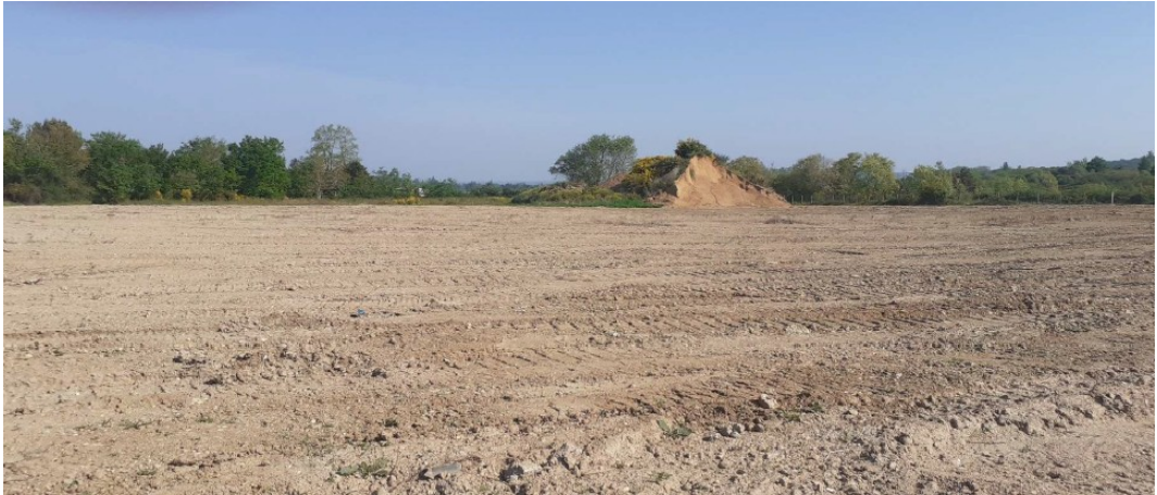
Couverture finale réalisée
