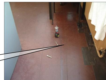
Fissure au niveau de la dalle béton
