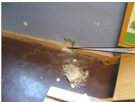
Joint de retrait au niveau de la dalle béton
