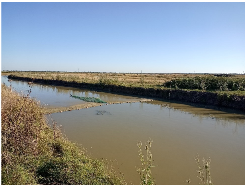
Figure 14. Station TE-A sur zone secteur hors UHC
