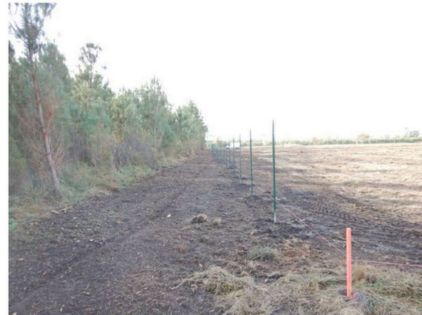
Entame de la pose de la clôture : mise en place des piquets
