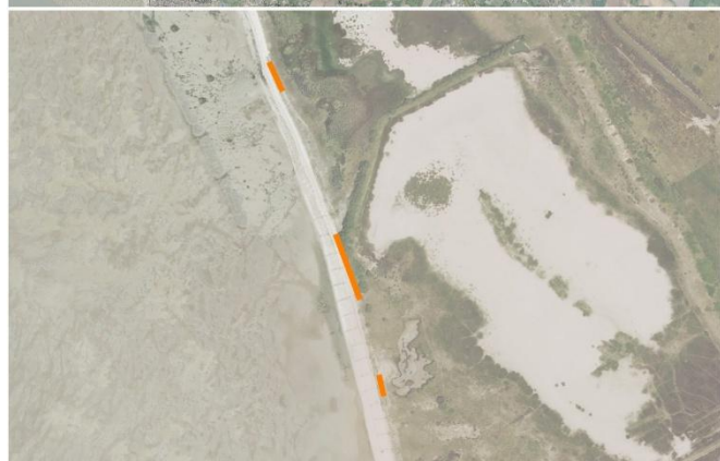
Localisation des 3 zones de remblai (en orange)
