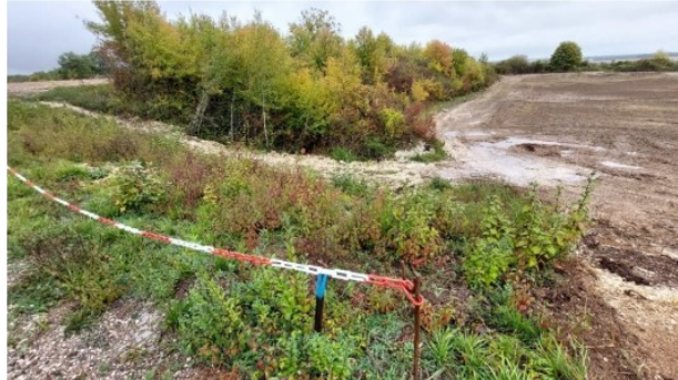
Balisage de mise en défens par piquet renforcé par chaîne suite à broyage de fruticée à éviter
