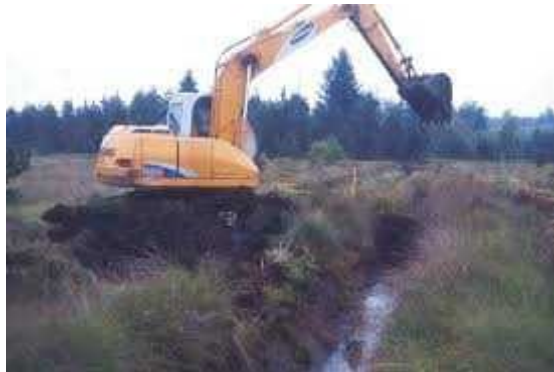
Comblement de drains
