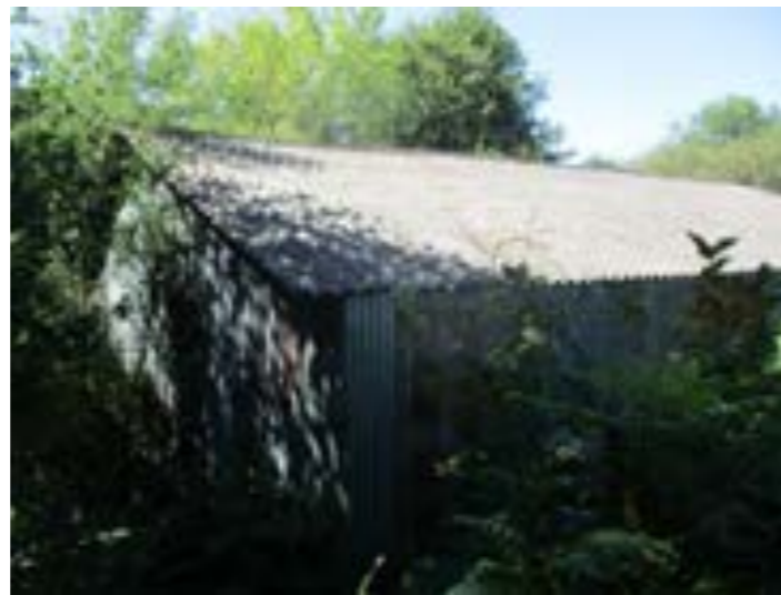
Figure 23 : Bâtiment abandonné © ETEN Environnement
