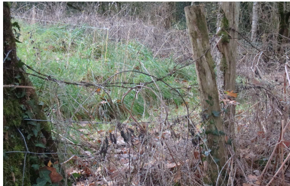
État de la clôture en partie Nord Ouest
