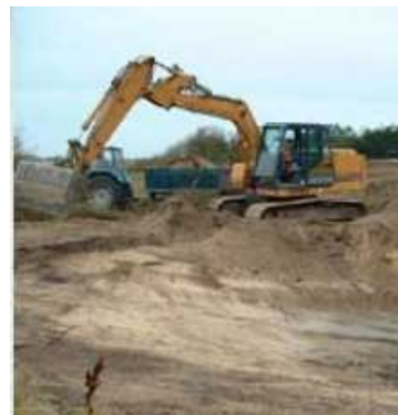
Reprofilage de pannes arrière dunaires
