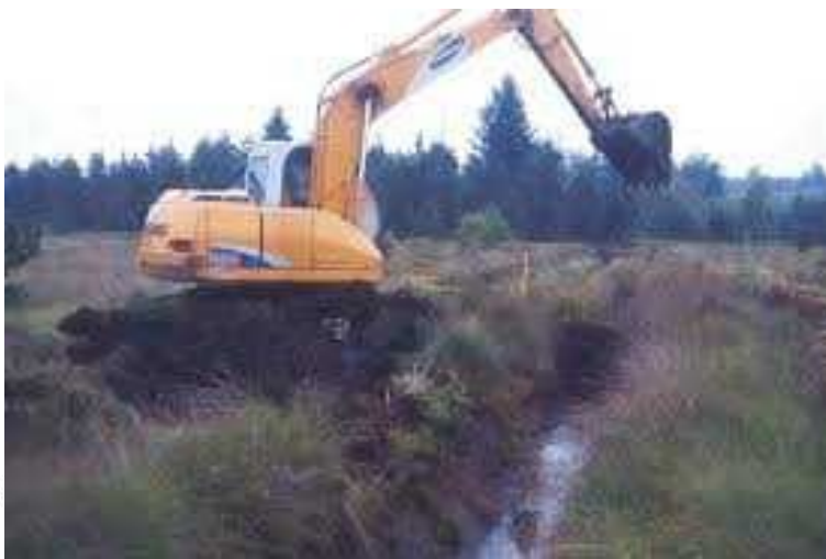
Comblement de drains
