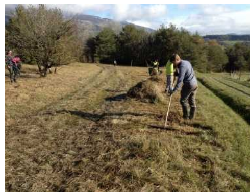
Le recours à des moyens d'intervention légers ou lourds dépend de la taille du chantier, de sa pénibilité, de la portance du terrain
