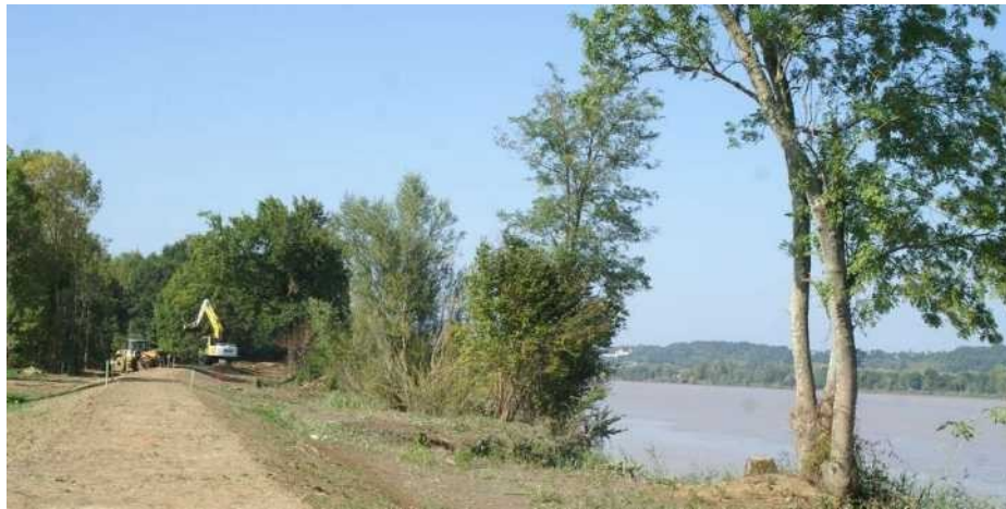
Travaux digues de St Pardon - 33 (ASA Vayres)
