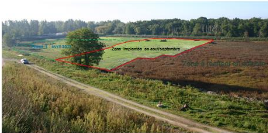
Etat du bassin Saugnac au 04 octobre 2017, vu depuis le CSDU
