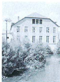
L'atelier de réparation
