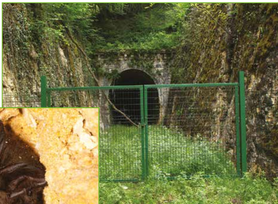
Aménagement à l'entrée du tunnel
