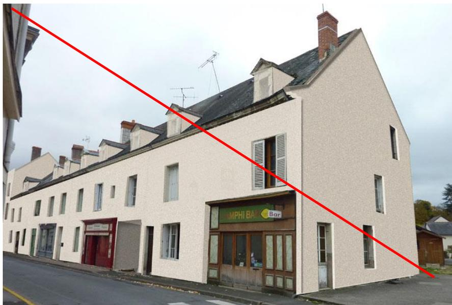
Photo 2 : Photo montage : doublage par l'extérieur avec enduit en parement
